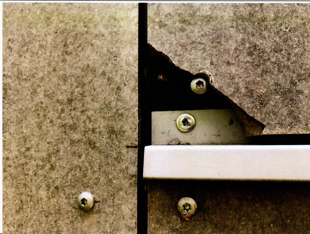
Nolauzts stūris fibrocementa loksnē
