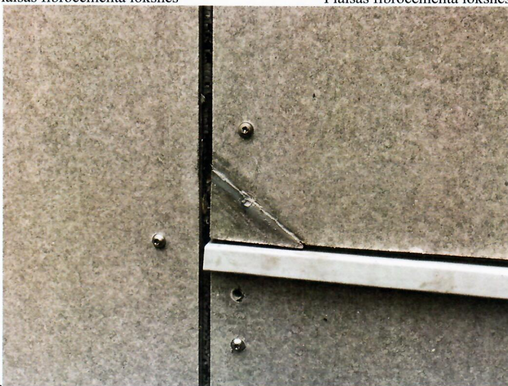
Nolauzts stūris fibrocementa loksnē
