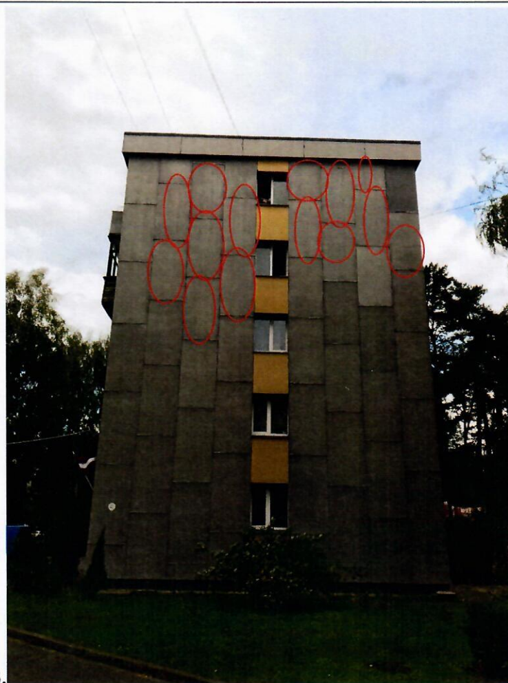
Plaisu atrašanās vietas fibrocementa loksnēs
